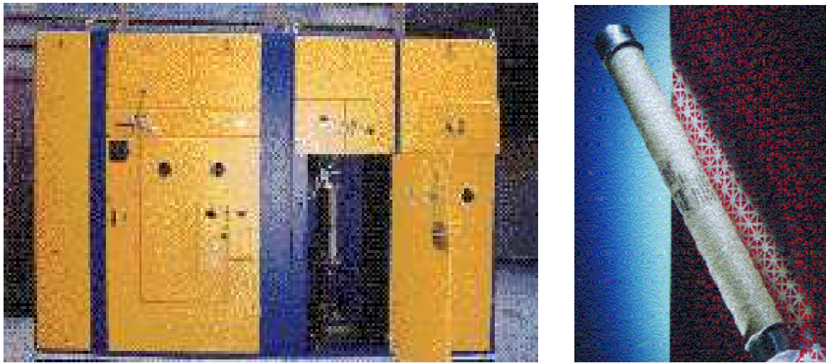
Figure 3: fusibles type intérieurs installés au primaire d'un transformateur
