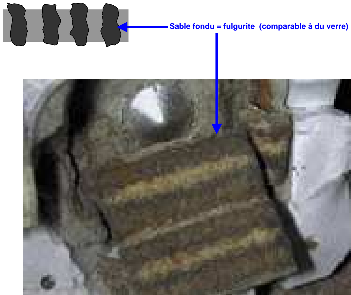
Figure 9: élément fusible après l'interruption d'un court circuit
