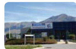
Site de La Mure - France
